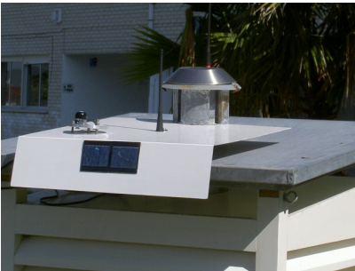
Fig. 4. Fase de Montaje exterior con Antena, Piranómetro y Células
